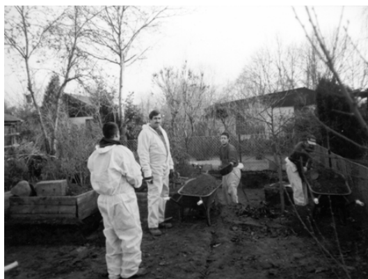
Abb. 8: Auskoffnung des Bodens (40 cm)
