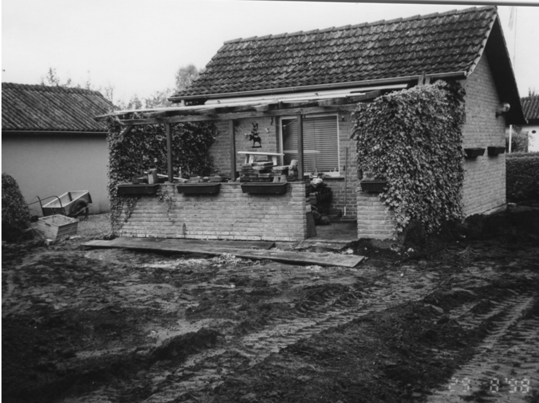
Abb. 9: Aufbringen von Muttererde auf die sanierten Flächen.
