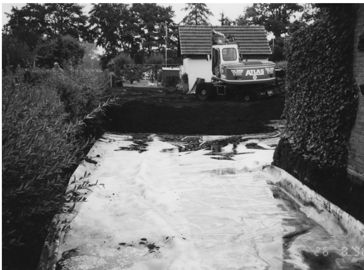
Abb. 5: Anschließend wurde ein Flies eingebracht, das Wasser durchlässig ist und als Grabesperre dient. Die Altlast darunter blieb an Ort und Stelle
