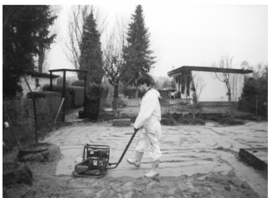
Abb. 11: Einbringen einer ersten neuen Bodenschicht
