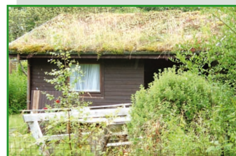
Extensive Dachbegrünung des Vereinsheimes
