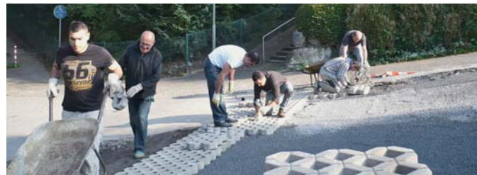
Eine neue Vereins-Einfahrt für den Kgv. „Windhügel“. Hier: die fleißigen Helfer bei der Baumaßnahme
