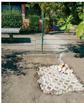
Das Werk der Fachmänner des Kgv. „Jungfernhöhe“: der Wasserablauf der westlichen Dachhälfte.
