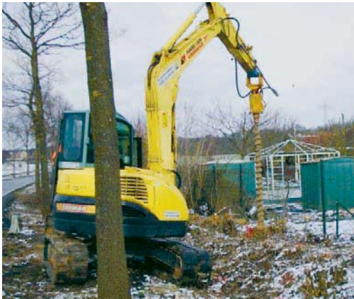
Bombenalarm im Kgv. „Naturfreunde Münster“ bei Bauarbeiten am Heumannsweg. Zum Glück stellte es sich als falscher Alarm heraus!
