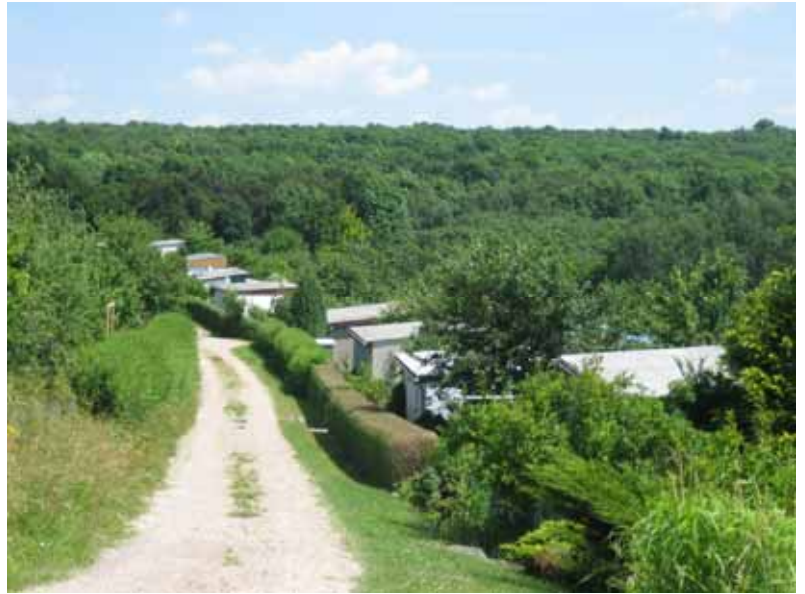
Foto: Weeber+Partner In die Landschaft gebaute Kleingartenanlage Monkeshofer Höh, Neubrandenburg
